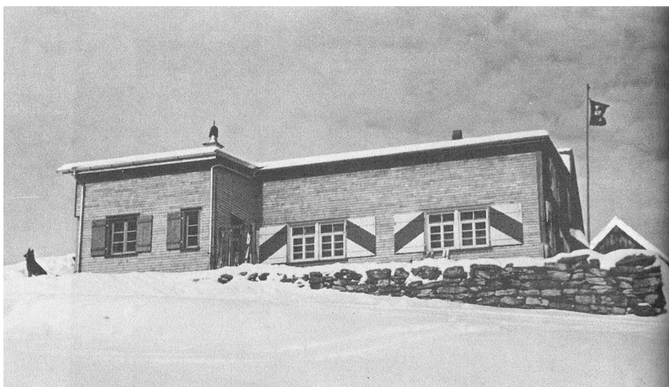
Clubhütte mit Anbau im neuen Gewand
