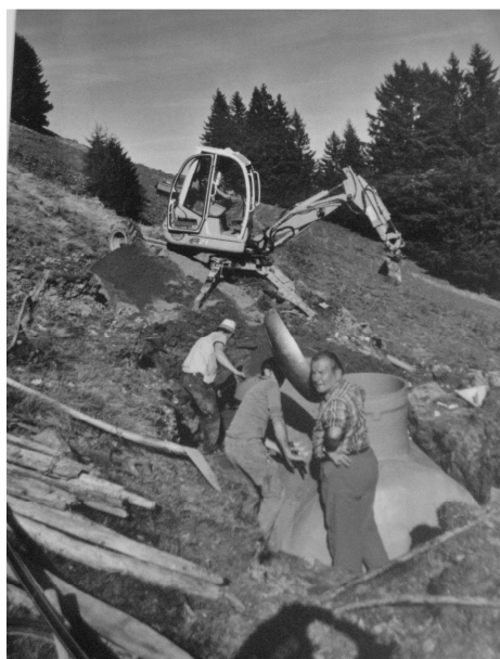
Maschinelle und manuelle Grabarbeiten.
