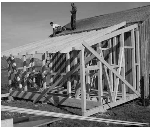
Der Holzschopf wächst - das Balkengerüst steht.
