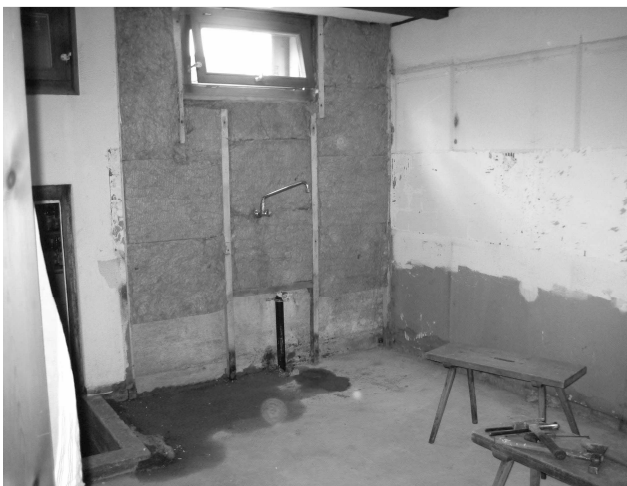
Die alte Küche ist herausgerissen.
